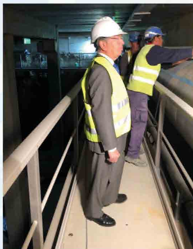
OBRA TANQUE TORMENTA DOS HERMANAS
